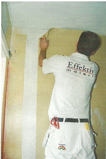
Stefan Gränsmark sätter upp tapeten ovanpå ett tjockt lager våtrumslim.
