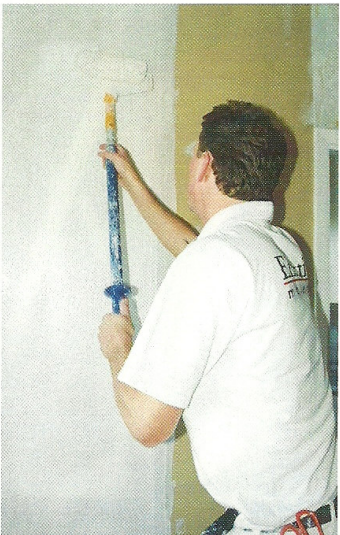
Det är noga med underarbetet när man hänger radontapeten, säger Stefan Gränsmark.
